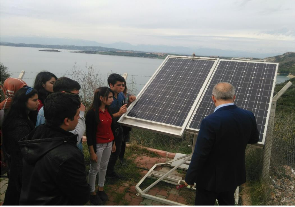
Fotovoltaik-Termal Güneş Panellerinin Performansının Araştırılması ve Eğitimi- Çukurova Üniversitesi Kampusü-Adana
